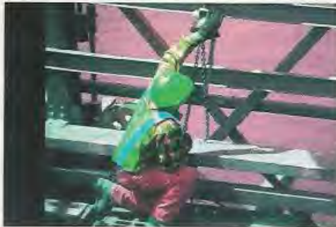
Qualitätssicherungssystem für die Baustelle
